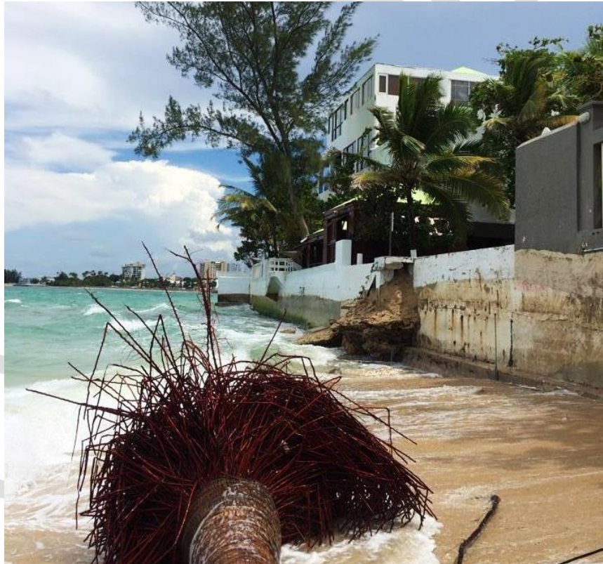
Foto 9. Erosión costera en el sector de Ocean Park.
