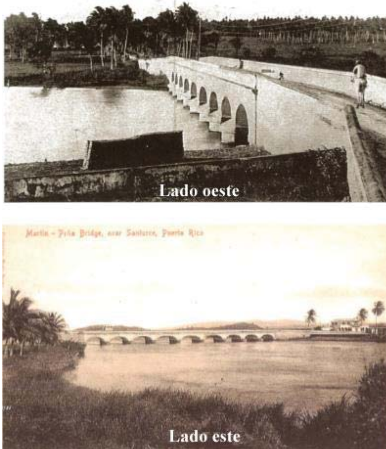
Figura 1-4. Fotografías del lado este y oeste del puente de hormigón sobre el CMP (circa, 1890)
